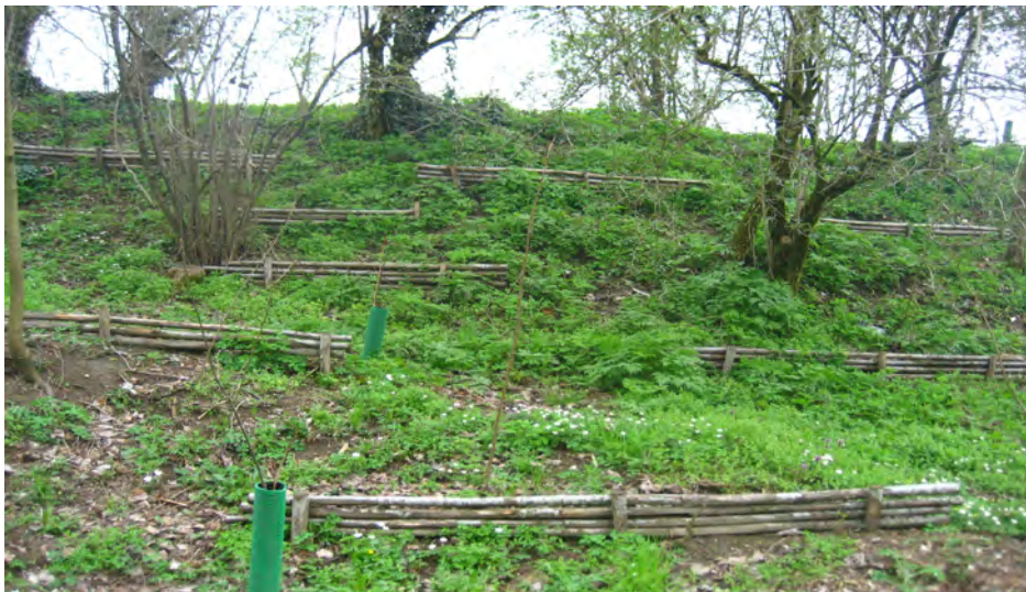
Esempio 2. Miglioria forestale con intervento di ingegneria naturalistica sul versante
