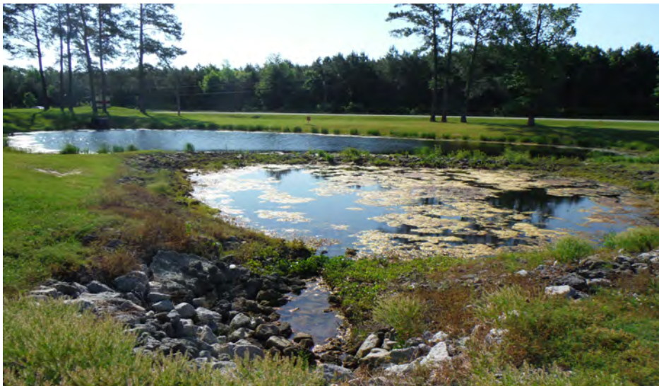
Esempio 2. Stagno semi-naturale in ambito urbano per la fitodepurazione delle acque
